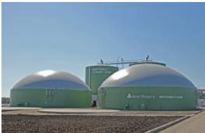
Рис. 4.14. Биогазовая станция «Лучки»
